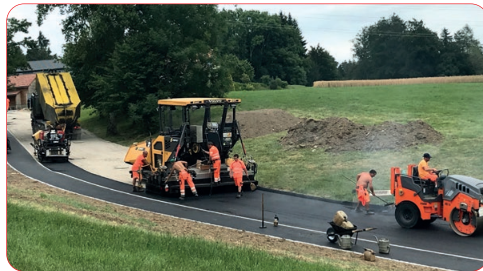
Goudronnage de la route de Compostelle le 11 juillet 2019
