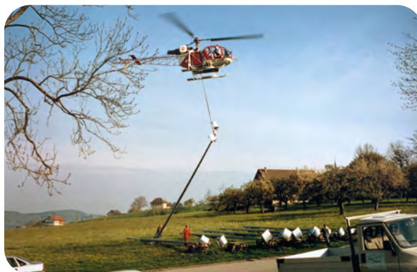
1991 - Pose des projecteurs au terrain de foot de Chapelle
