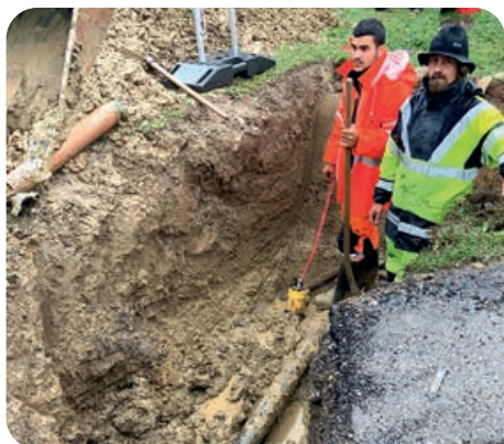
19 septembre 2021 - Aucun répit pour le travail, même le dimanche et sous la pluie...
